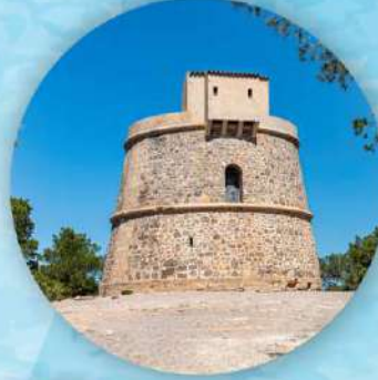
TORRE DE CAMPANITX Torre de defensa
